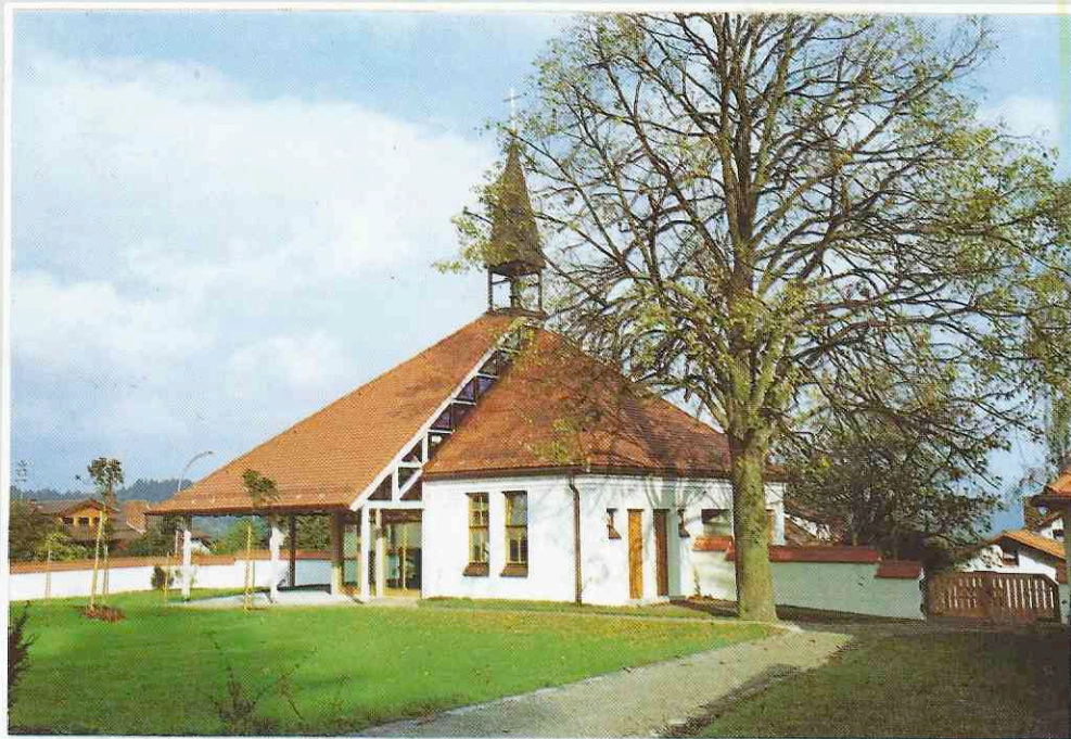
Ansichten zur alten Linde mit Aussegnungsgebäude
