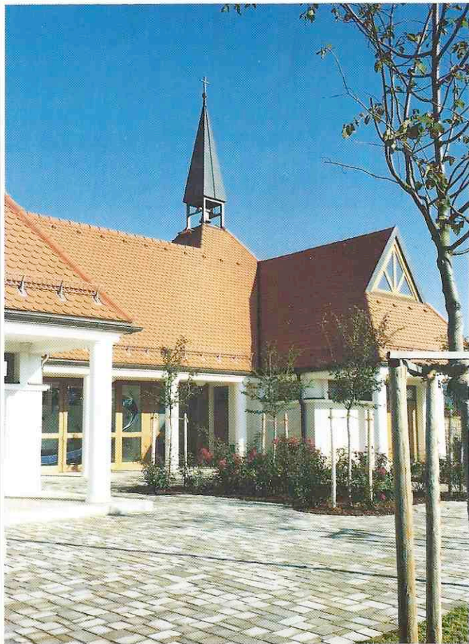
Hof vor Aufbarungsraum
