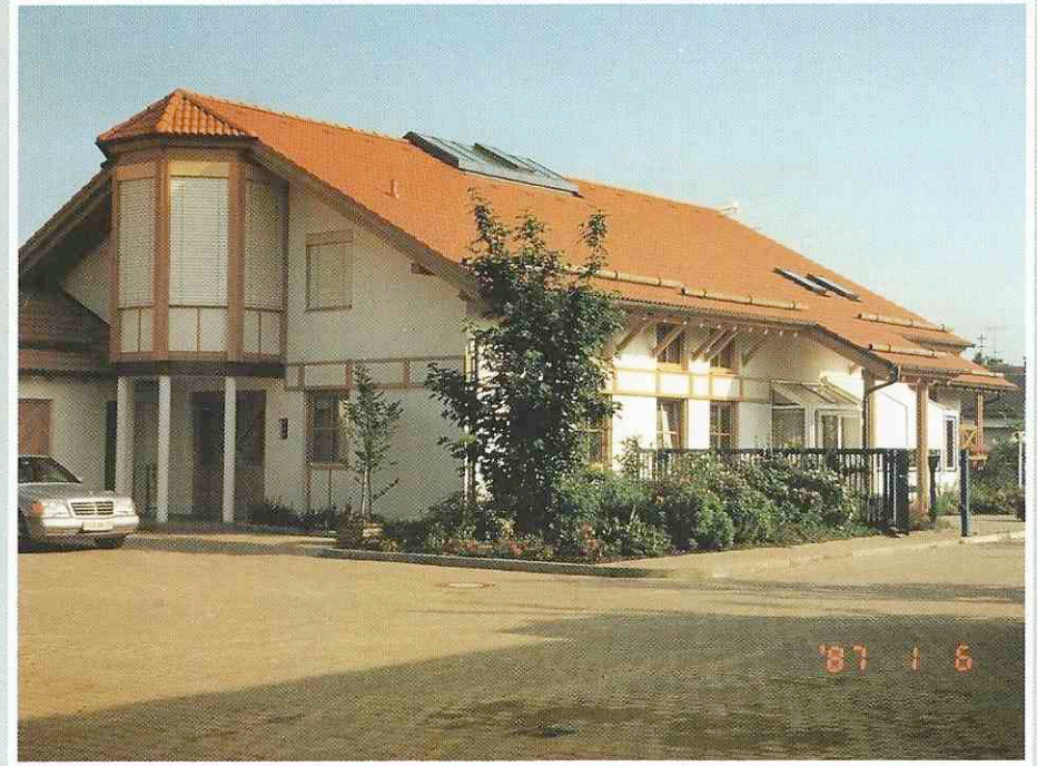
Ansicht bei Zufahrt
